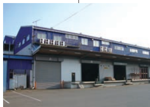
福山(広島)物流倉庫
