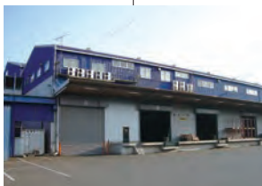
福山(広島)物流倉庫
