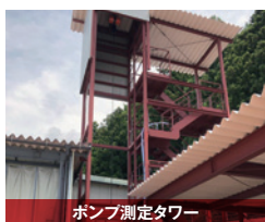
ポンプ測定タワー
