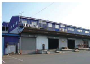
福山 (広島) 物流倉庫
