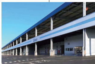
清水 (静岡) 物流倉庫
