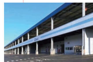
清水(静岡)物流倉庫
