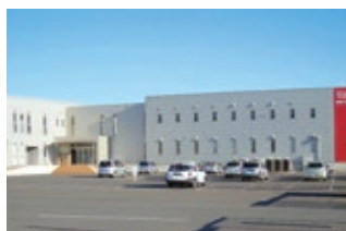
福山(広島)物流倉庫
