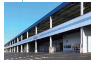
清水(静岡)物流倉庫
