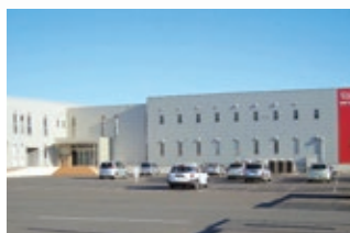
福山(広島)物流倉庫
