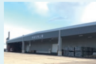
小樽(北海道)物流倉庫
