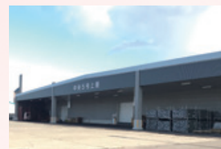
小樽(北海道)物流倉庫
