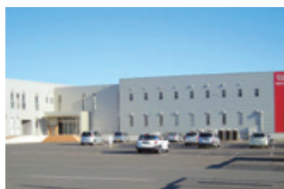
福山(広島)物流倉庫
